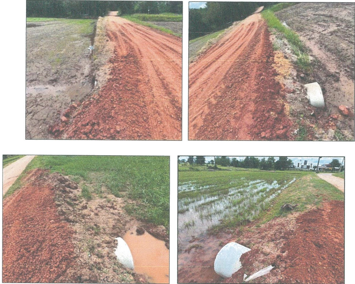
๒๐. โครงการวางท่อระบายน้ำภายในตำบลเมืองเกษตร
