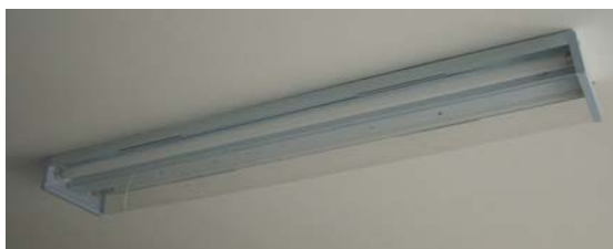
ภาพที่ 19 หลอดไฟมีฝาครอบใสเพื่อไม่ให้ความเข้ม ของแสงลดลง
