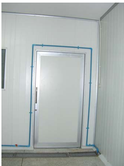
ภาพที่ 8 ตัวอย่างวัสดุที่ใช้ทำประตูในโรงฆ่าสัตว์ ซึ่งเป็นพลาสติก หรือสแตนเลส
