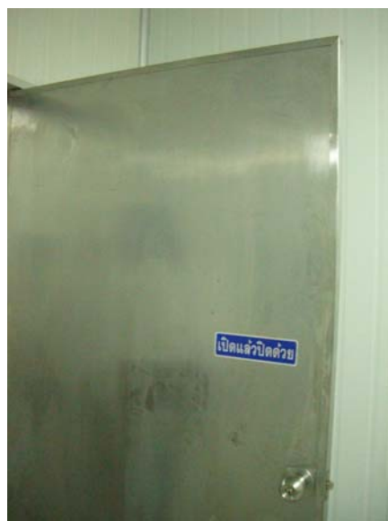
ภาพที่ 8 ตัวอย่างวัสดุที่ใช้ทำประตูในโรงฆ่าสัตว์ ซึ่งเป็นพลาสติก หรือสแตนเลส
