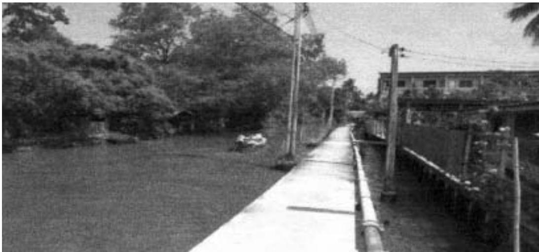
ภาพที่ 2 การวางท่อและการปักเสาไฟฟ้าในน้ำ
